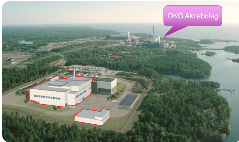
Figur S-6. Inkapslingsanläggningen placeras i direkt anslutning till Clab och de båda anläggningarna ska drivas som en integrerad anläggning, benämnd Clink. De röda markeringarna anger vad som är fotomontage.
