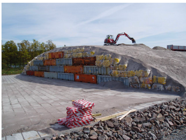
Bild på markförvaret vid Oskarshamns kärnkraft
