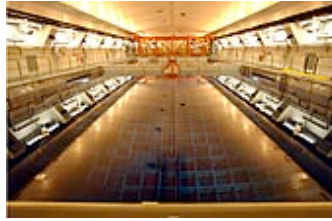
Bassäng för använt kärnbränsle.
