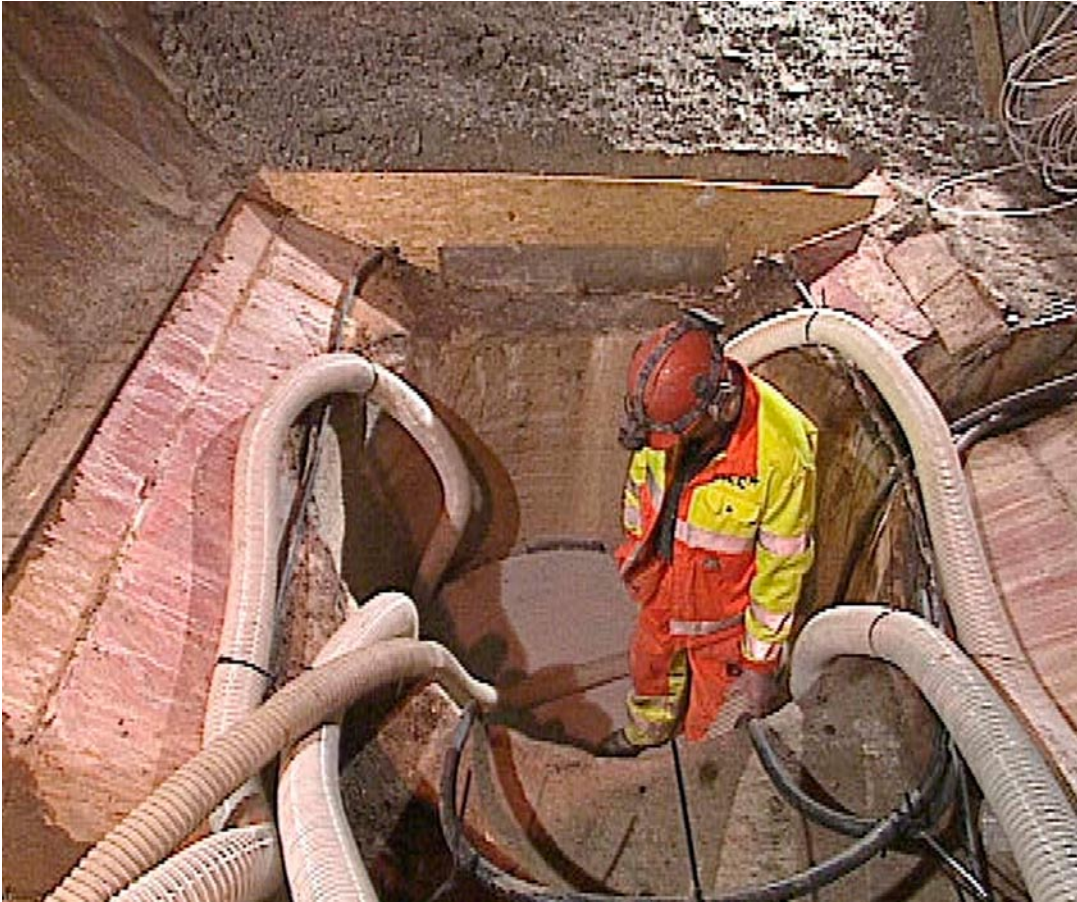
Spalten mellan bufferten och deponeringshålets vägg fylls med pelletter.
