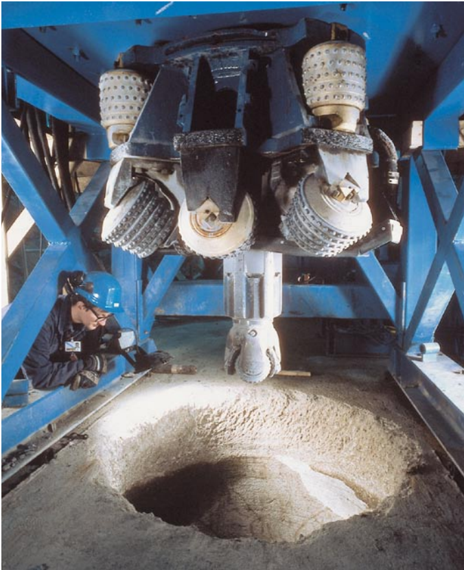
Borring av deponeringshål.
