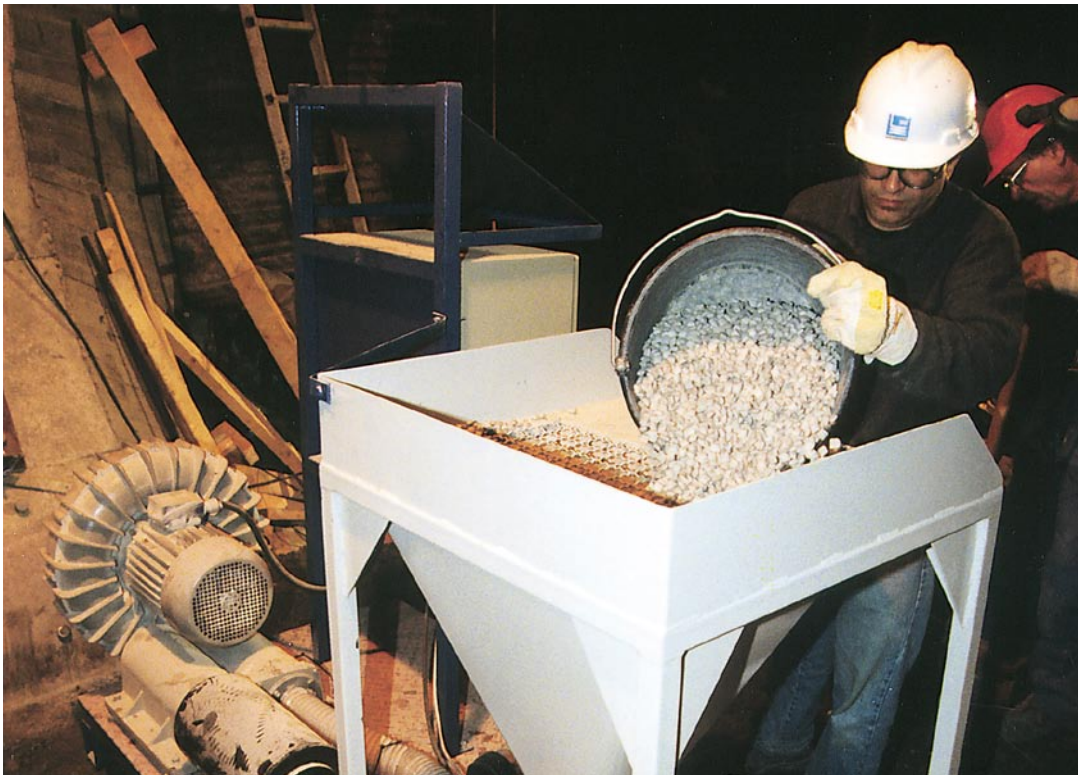
Tätning med bentonitpelletar.
