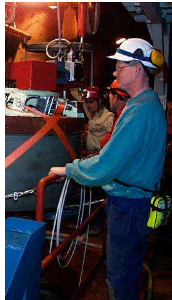
Placering av bentonitring i ett deponeringshål.
