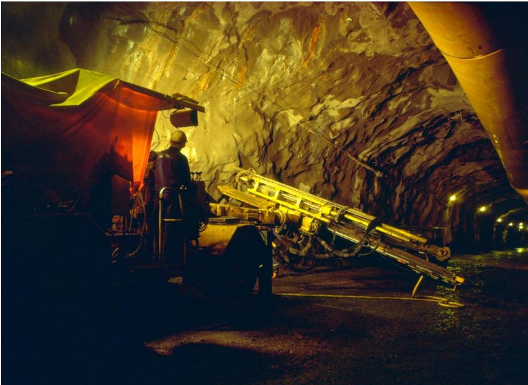
Från bygget av SFR.
