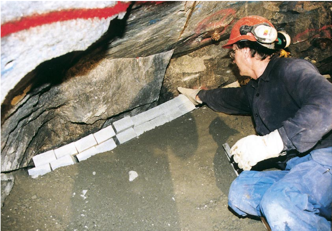
Området mellan återfyllningen och tunnelns tak måste på något sätt tätas med betontitlra.
