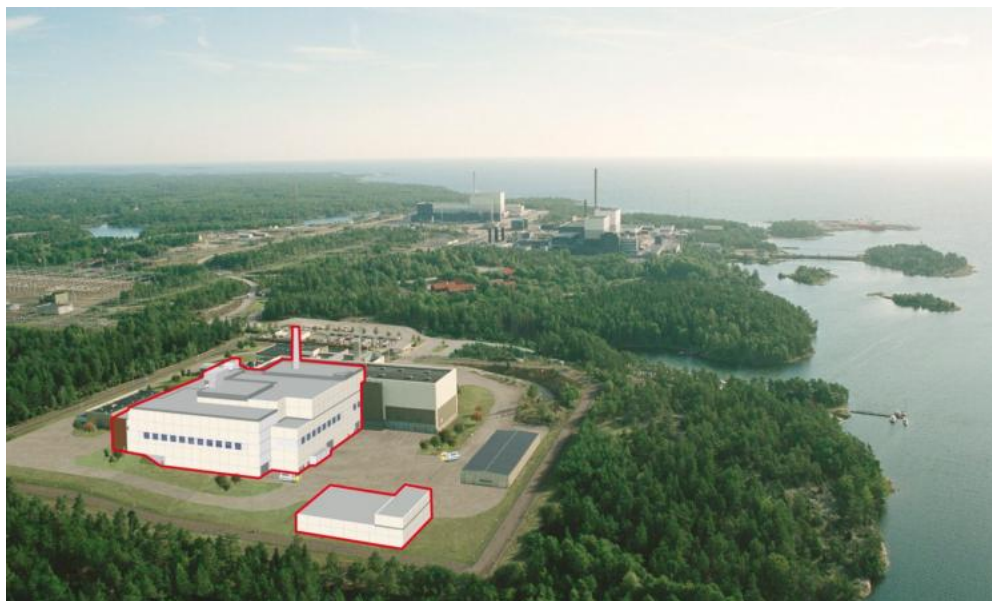
Figur 1. Fotomontage som visar hur inkapslingsanläggningen (rödmarkerade byggnader) placeras i direkt anslutning till Clab. De båda anläggningarna ska drivas som en integrerad anläggning, benämnd Clink.
