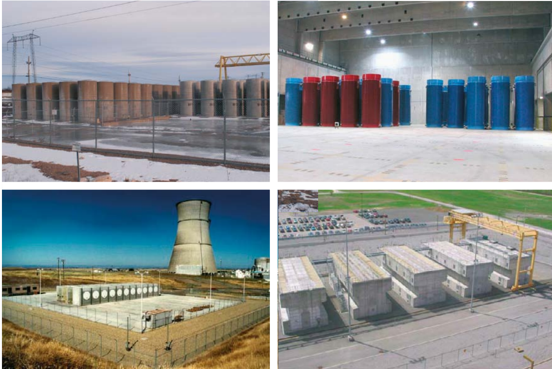
Figur 3-14. Exempel på anläggningar för torr lagring. Överst till vänster utomhuslagring av tjockväggiga cylindriska stålbehållare vid Point Lepreau Generating Station (Källa: NBPower Nuclear). Överst till höger CASTOR®-behållare (tjockväggig cylindrisk behållare av gjutjärn) i lagerbyggnad vid Gorleben i Tyskland (Källa: IAEA). Nederst till vänster utomhuslagring i NUHOMS® (tät stålbehållare) vid Susquehanna kärnkraftverk i USA (Källa: IAEA). Nederst till höger utomhuslagring i CANSTOR®-moduler (täta metallbehållare omgivna av en betongkonstruktion) vid Gentilly-2 i Kanada (Källa: Hydro Quebec).
