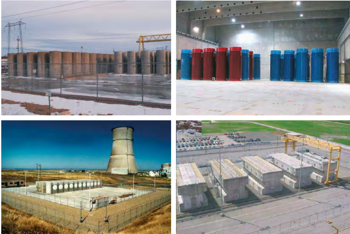
Figur 3-14. Exempel på anläggningar för torr lagring. Överst till vänster utomhuslagring av tjockväggiga cylindriska stålbehållare vid Point Lepreau Generating Station (Källa: NBPower Nuclear). Överst till höger CASTOR®-behållare (tjockväggig cylindrisk behållare av gjutjärn) i lagerbyggnad vid Gorleben i Tyskland (Källa: IAEA). Nederst till vänster utomhuslagring i NUHOMS® (tät stålbehållare) vid Susquehanna kärnkraftverk i USA (Källa: IAEA). Nederst till höger utomhuslagring i CANSTOR®-moduler (täta metallbehållare omgivna av en betongkonstruktion) vid Gentilly-2 i Kanada (Källa: Hydro Quebec).
