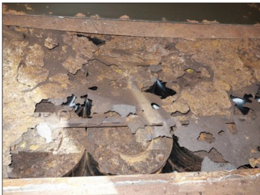
En halvhöjdscontainer i översta raden där hål i det obehandlade containerlocket uppstått från droppande grundvatten. Även de plåtfat som finns i containern har kraftiga rostangrepp. (Bild från SSM)
