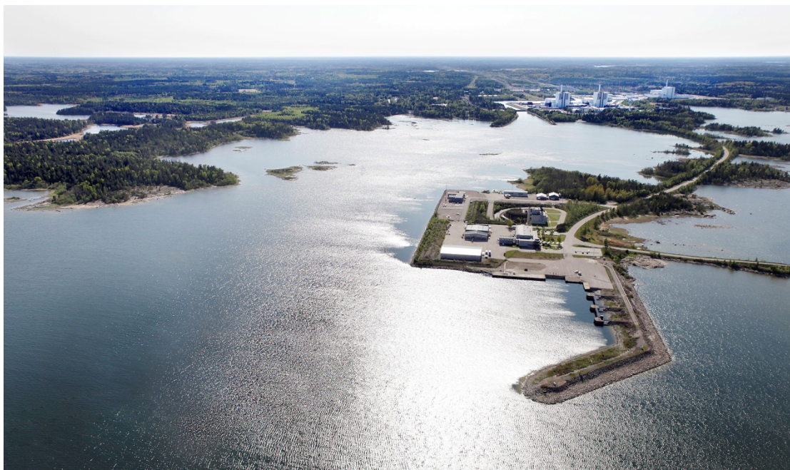
Figur 2. Forsmarks hamn, SFR och Forsmarks kärnkraftverk.
